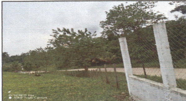
Foto 1: Remozamiento para la continuidad de muro perimetral del establecimiento.
