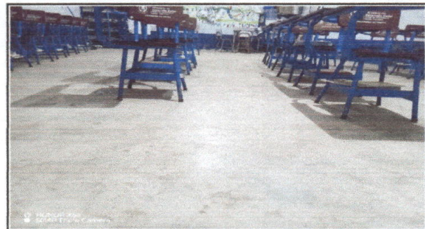
Foto 4: Remozamiento de piso para aulas del establecimiento.
